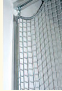
壁にはネットBOXバーで固定 サイドポールにネットBOXバー取付け
