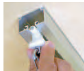
①ランナーをレールの溝に差込みます。
