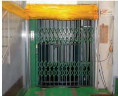
●開口部にビニールシャッター
