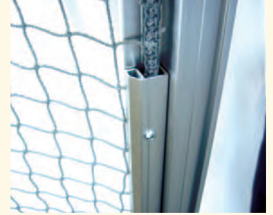
壁にはネットBOXバーで固定 サイドポールにネットBOXバー取付け
