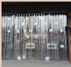
外部出入口に
