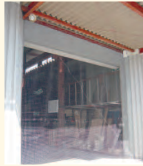
壁にはネットBOXバーで固定 サイドポールにネットBOXバー取付け
