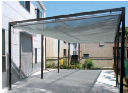
●工場休憩場の日除け
